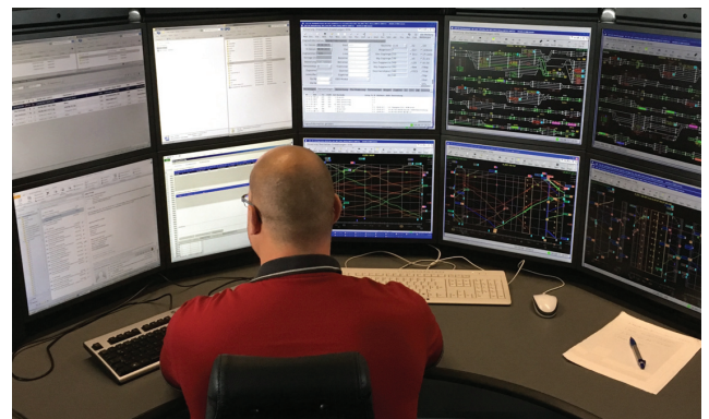
// Die Disponenten der ÖBB haben an modernsten Monitorwänden das Schienennetz im Blick
